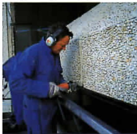
VOOR 3626 METER VERTICALE DILATATIEVOEG WERDEN 1086 KITWORSTEN A 600 ML GEBRUIKT.
