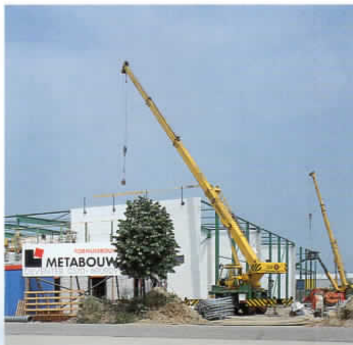
DE VESTIGING BESTAAT 8200 VIERKANTE METER. DAARVAN IS RIJIM 4000 M2 BEBOUWD.
